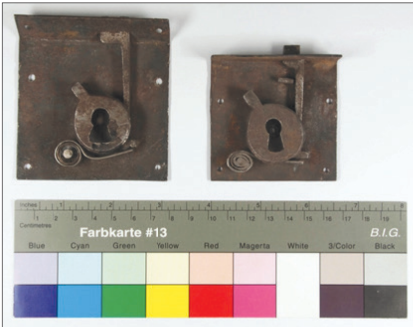
Afb. 9 Het binnenwerk van enkele sloten voor restauratie, © Universiteit Antwerpen/Isabel Osselaere.
